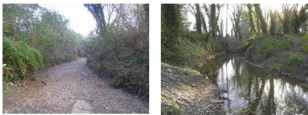
Canal à l'amont immédiat de la restitution dans le Gardon à Moussac
